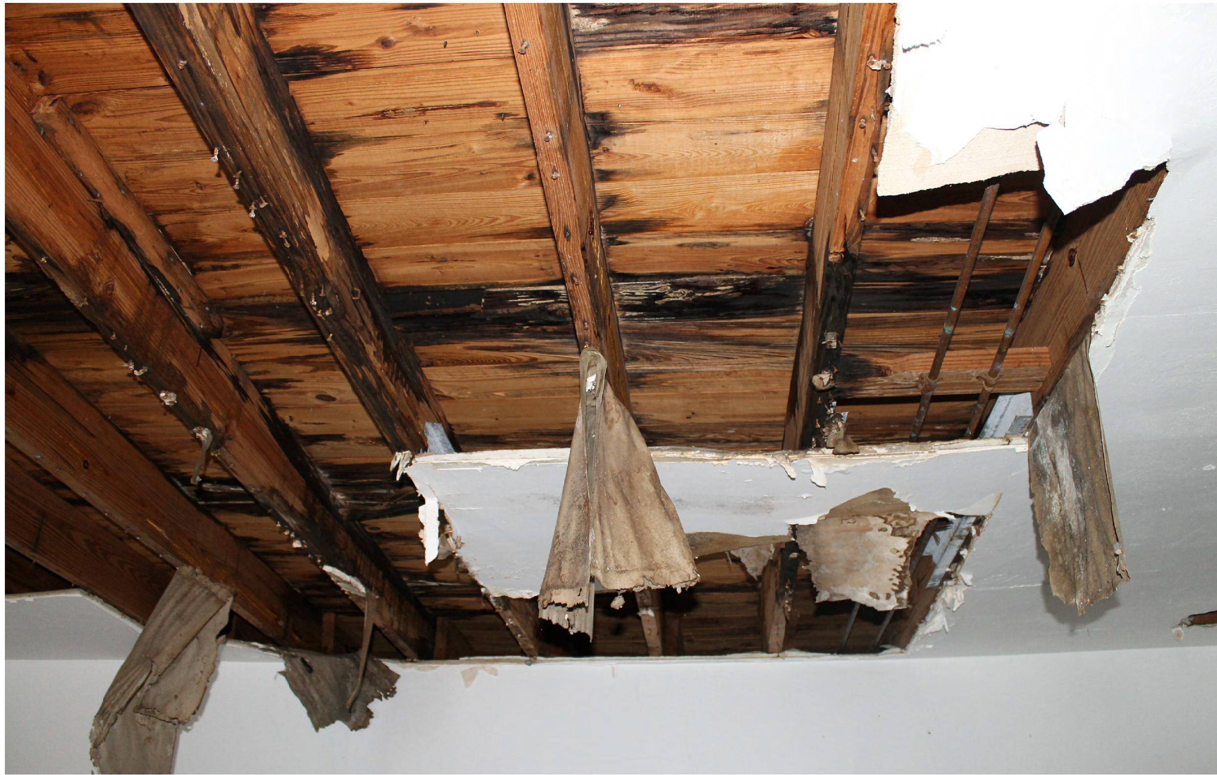
1 INTERIOR WATER DAMAGE SCALE: N.T.S.
