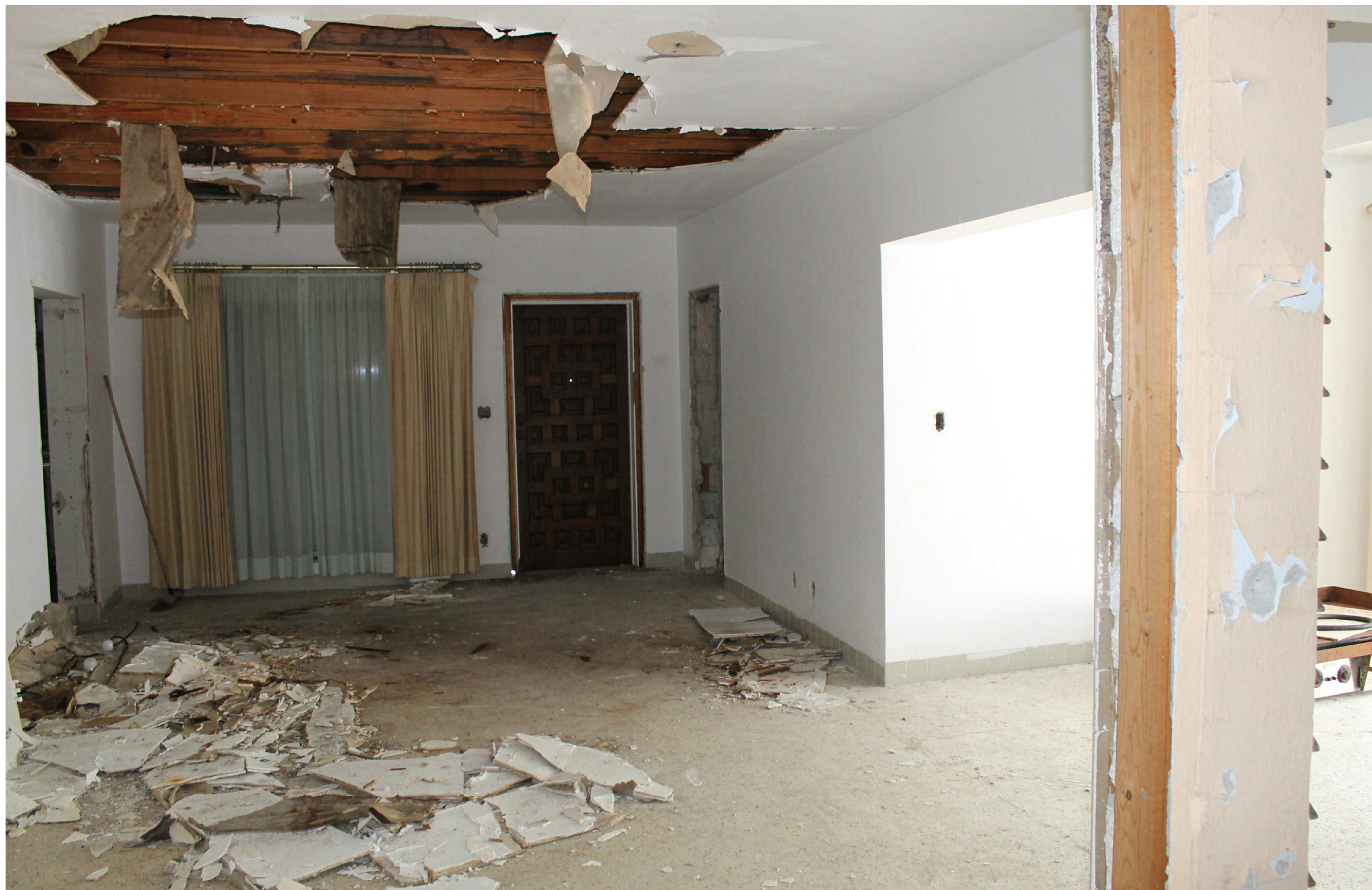
3 INTERIOR WATER DAMAGE SCALE: N.T.S.
