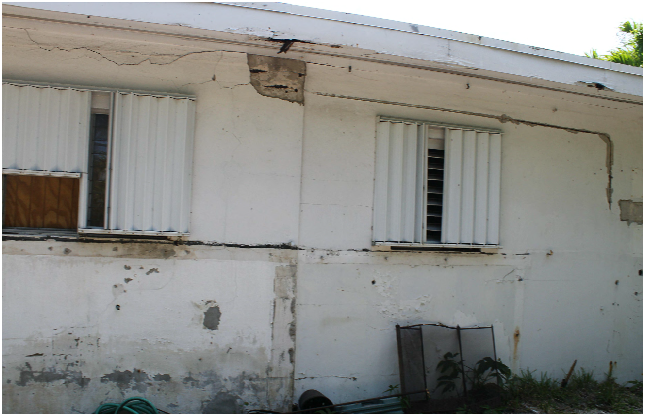
4 EXTERIOR SPALLING SCALE: N.T.S.
