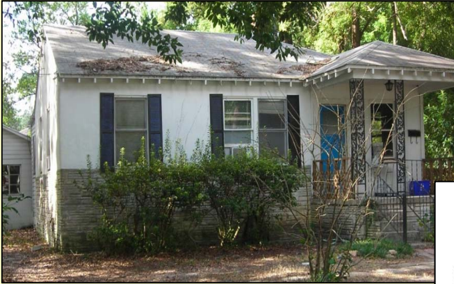
(DU20487) 4356 Bethwood Circle
