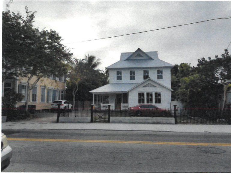
2 A3 PHOTOGRAPH OF EXISTING NORTH ELEVATION SCALE: N.T.S.
