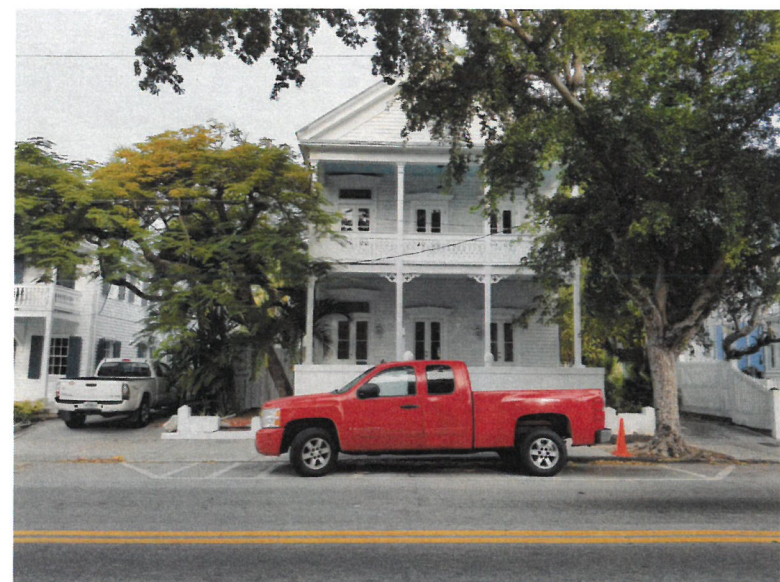
4 A3 PHOTOGRAPH OF EXISTING EATON STREET SCALE: N.T.S.
