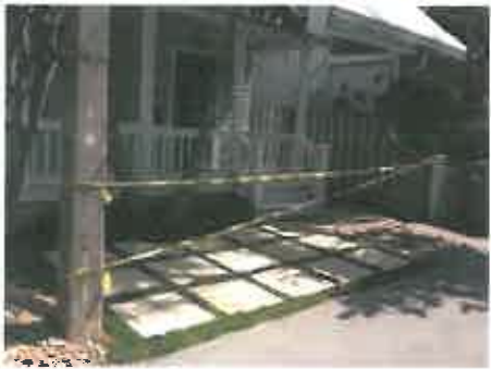
13-509 1110 Curry Lane - pavers 002.JPG 2623K
