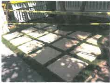
13-509 1110 Curry Lane - pavers 001.JPG 2608K
