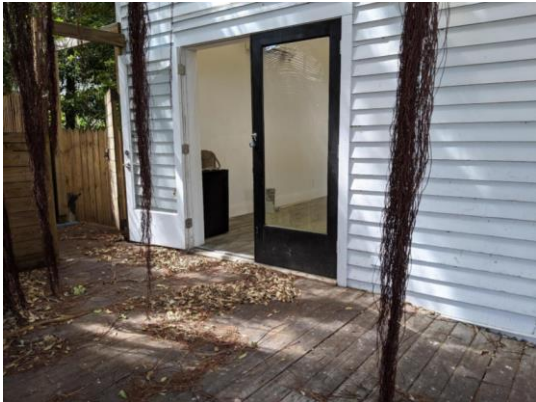
Rear door to ADA ramp
