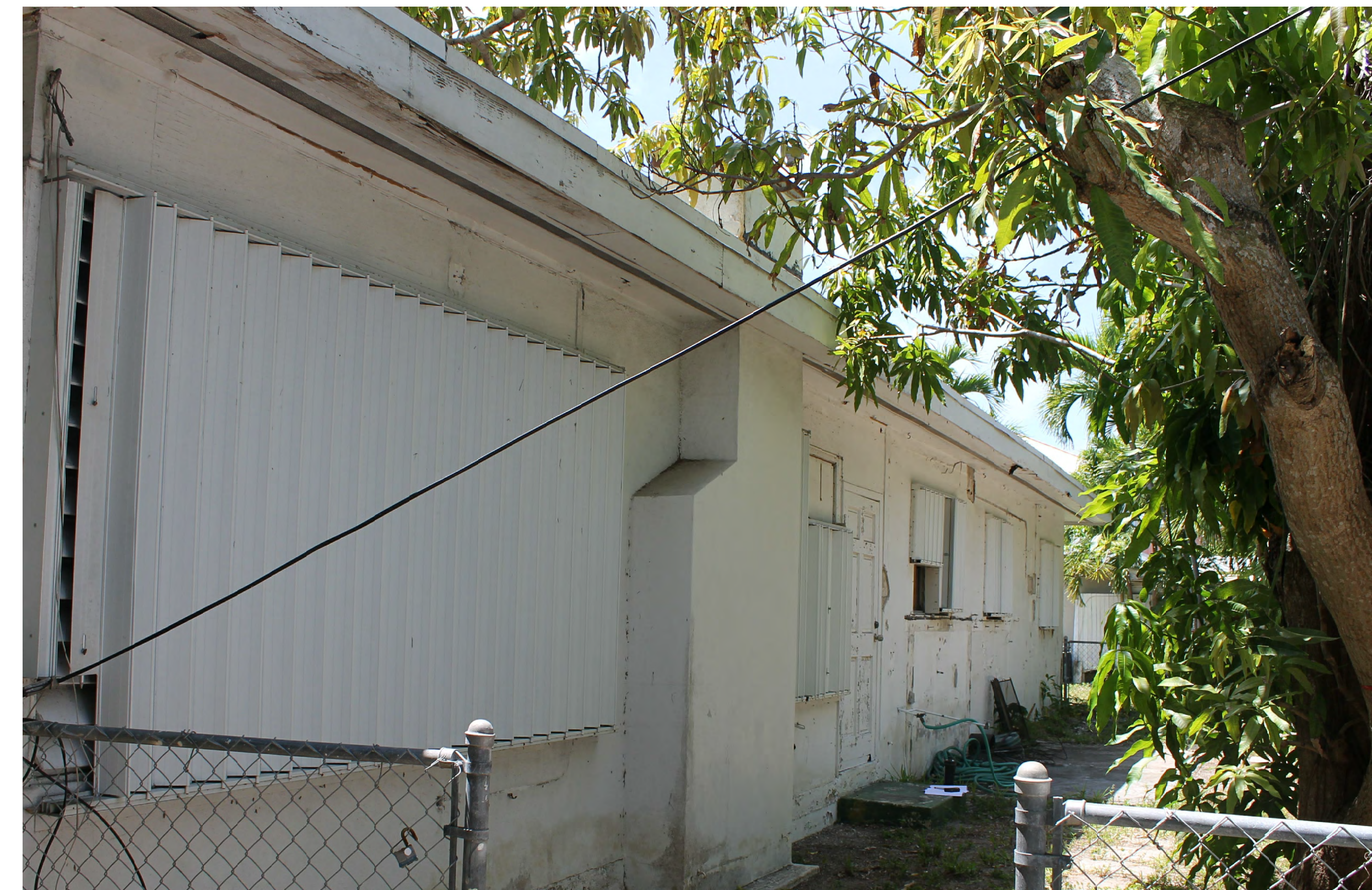
2 PHOTO OF EXISTING NORTH ELEVATION SCALE: N.T.S. A7
