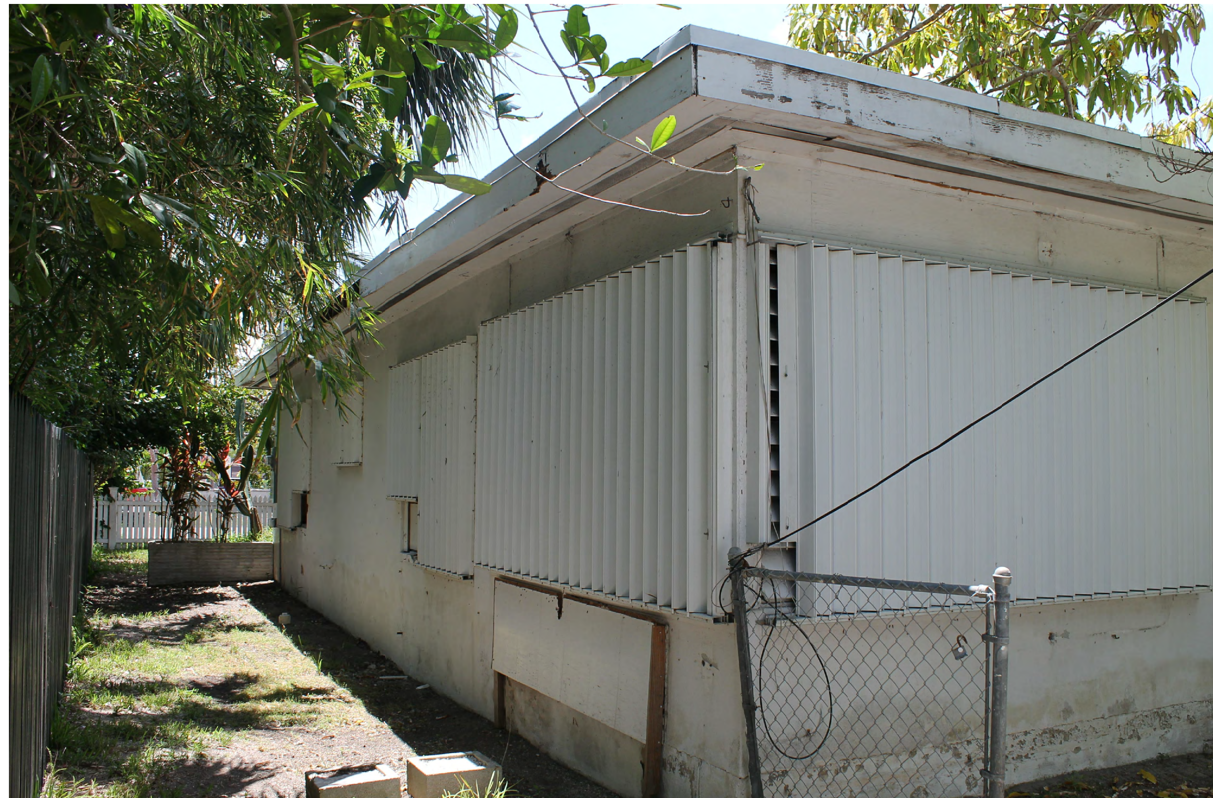
1 PHOTO OF EXISTING EAST ELEVATION SCALE: N.T.S. A7
