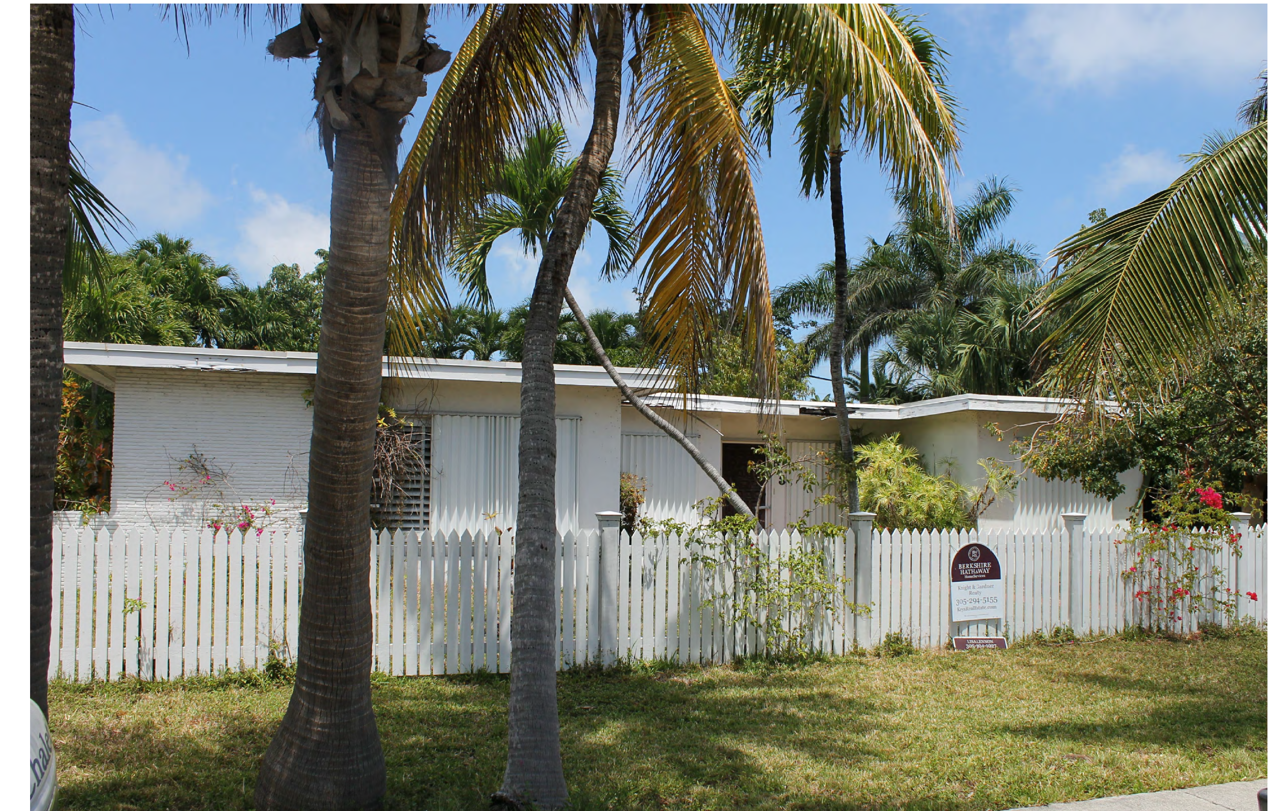
4 PHOTO OF EXISTING NORTH ELEVATION SCALE: N.T.S. A7
