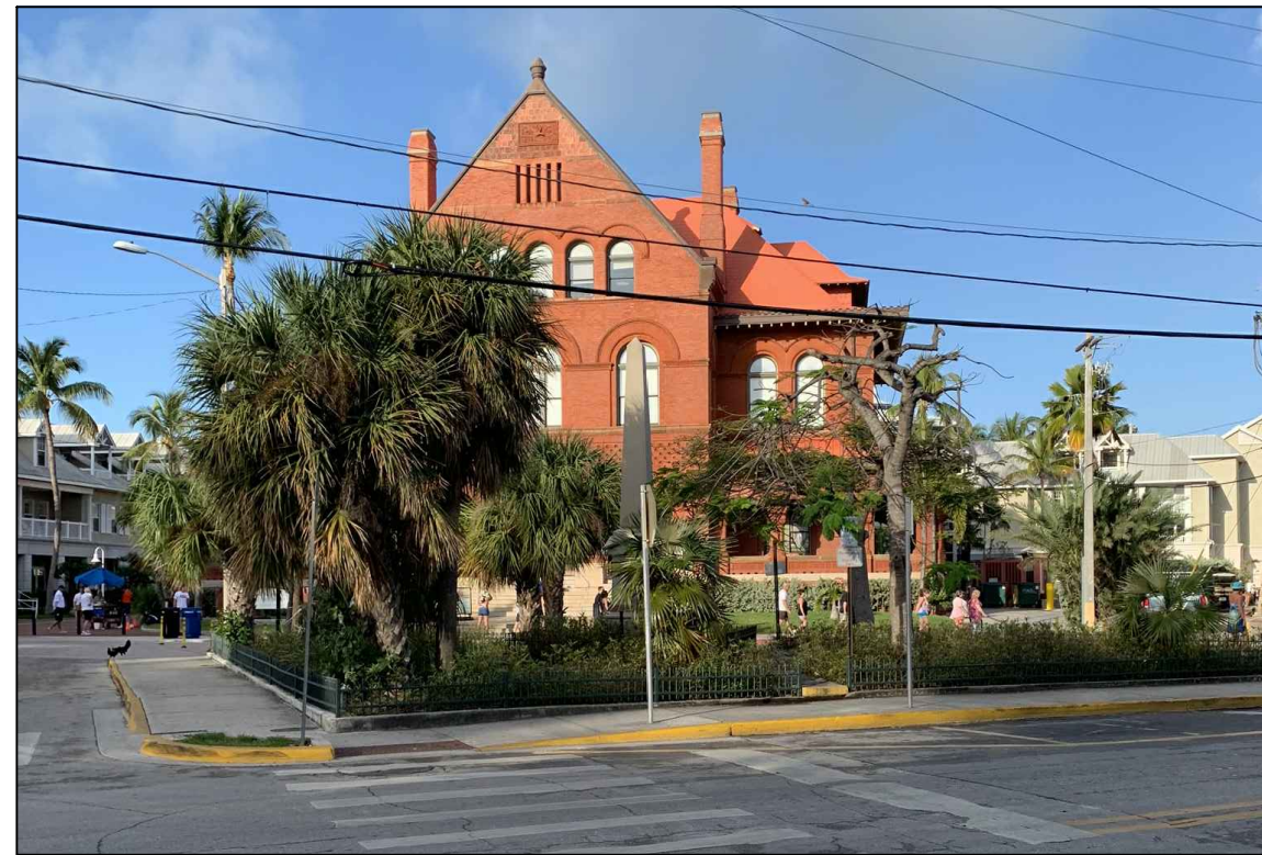
1 EX1.1 EXISTING PHOTO CLINTON SQUARE -1 SCALE: N.T.S.
