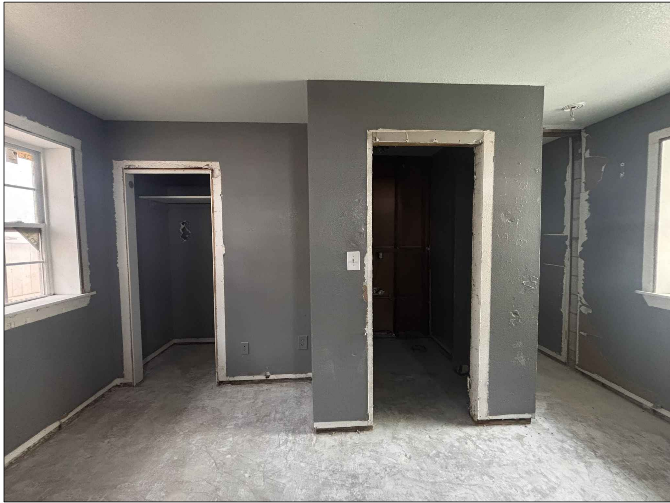
5 A5 INTERIOR OF THE HOUSE N.T.S.
