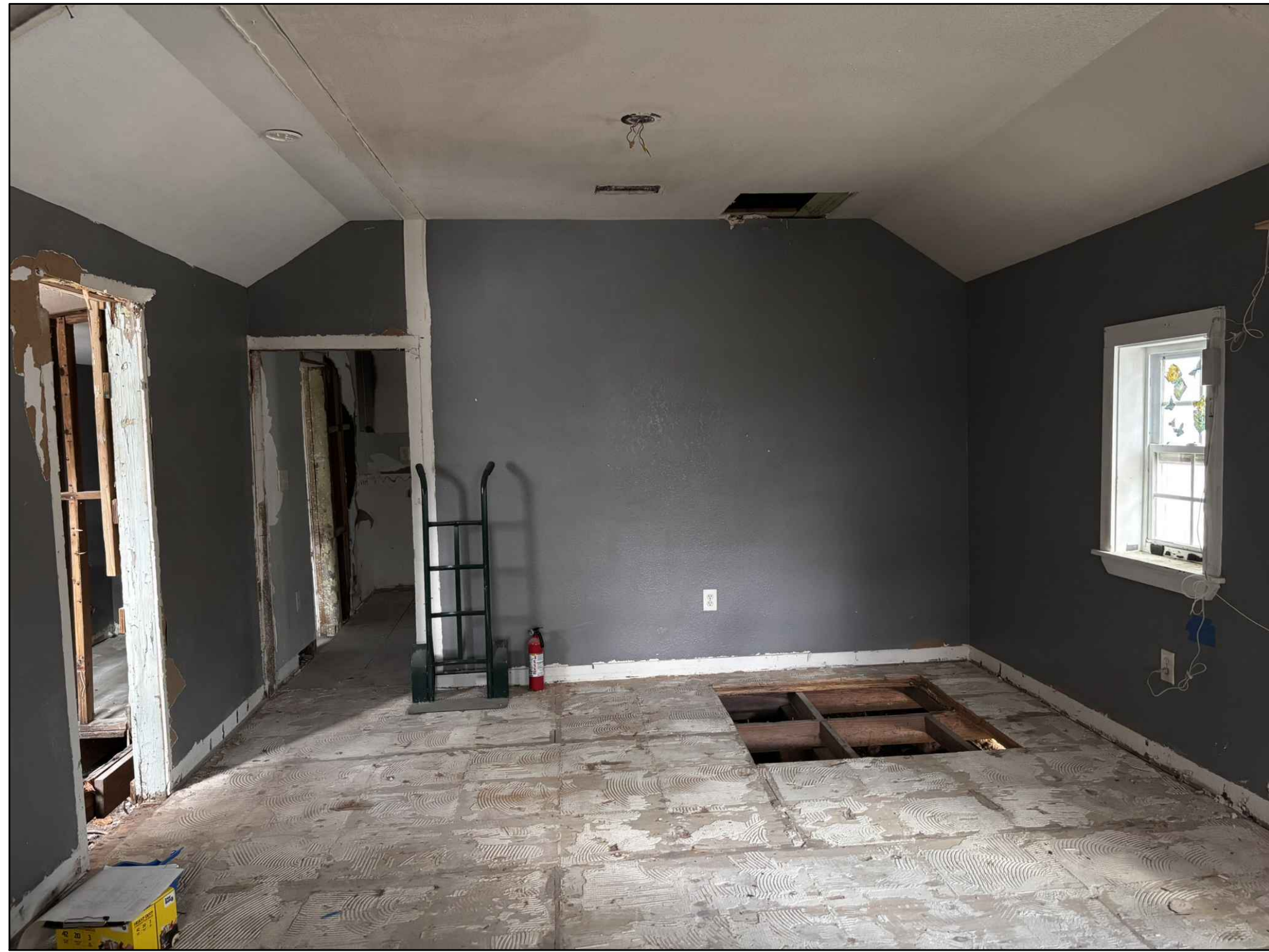
4 A5 INTERIOR OF THE HOUSE N.T.S.
