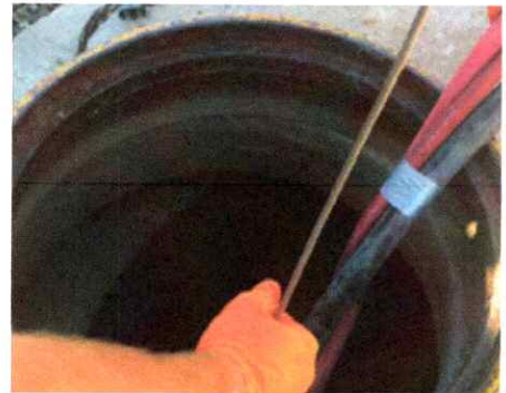
Rehab of manhole.
