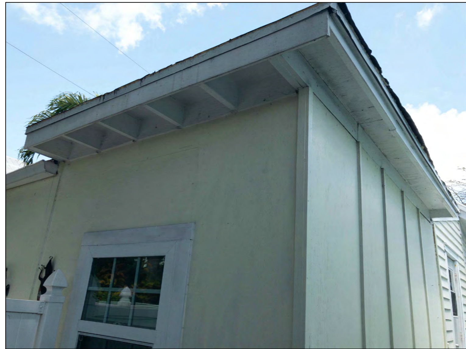
5 NON HISTORIC FLAT ROOF AT REAR SCALE: N.T.S.
