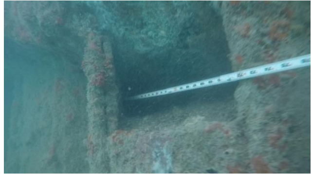
Figure 9: B-B, STA 0+35, 14"x14"x39" Void
